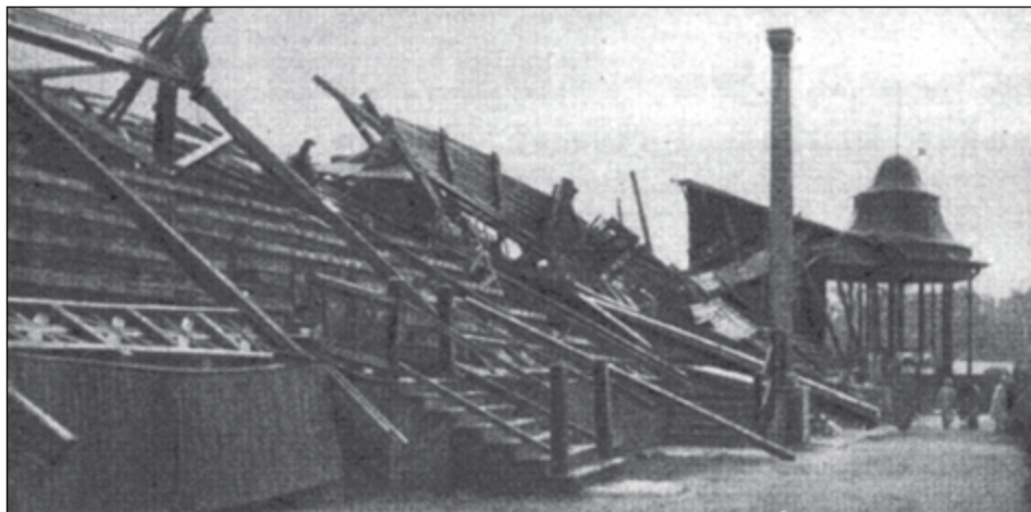
Fot. 16. 1935 r. Widok zniszczonej przez wicher trybuny na stadionie krakowskiej „Wisły” (zdjęcie z 1935 r.)
